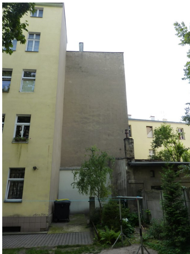
Fot. 2 Elewacja północna
