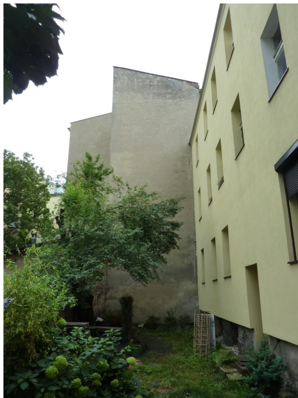
Fot. 1 Elewacja zachodnia
