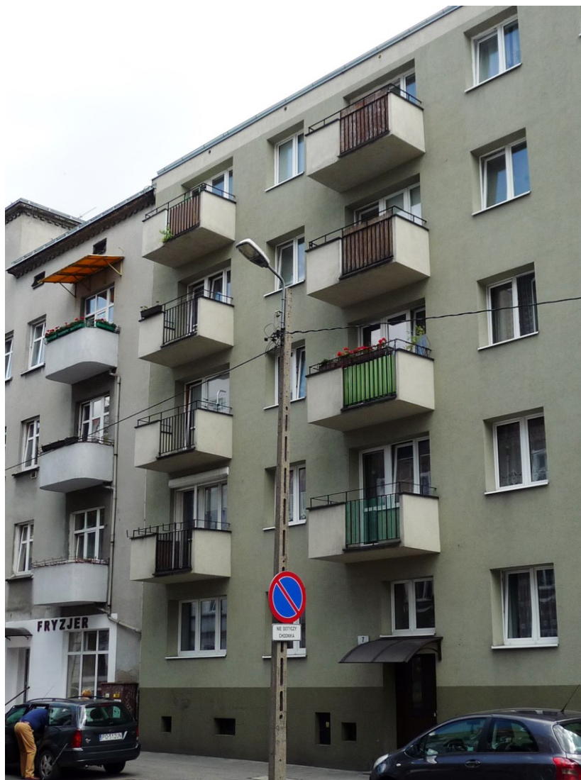
Fot. 1 Fragment elewacji od strony ulicy Łukaszewicza
