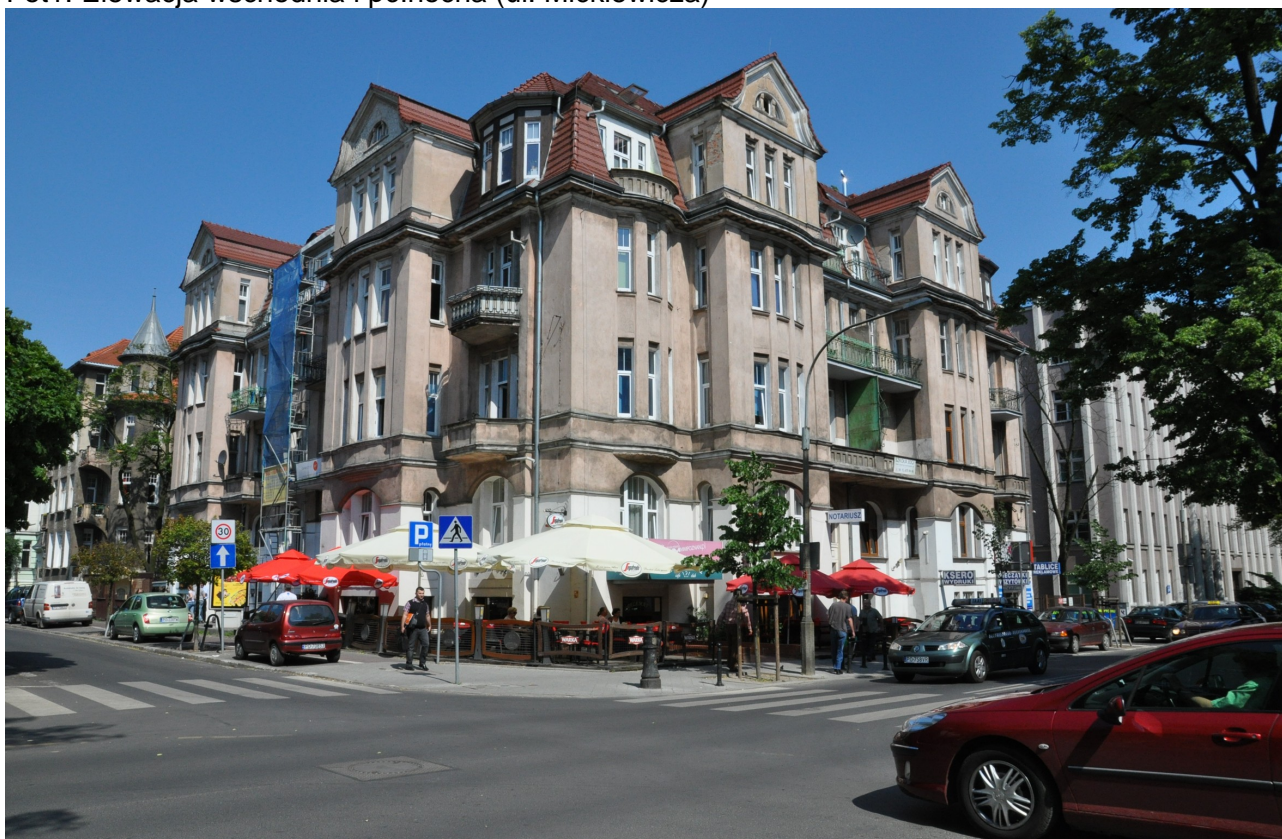
Fot1. Elewacja wschodnia i południowa (narożnik ulic Mickiewicza/Słowackiego)
