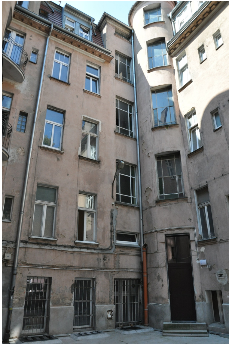
Fot. 7 elewacja wewnętrznej dziedzińca
