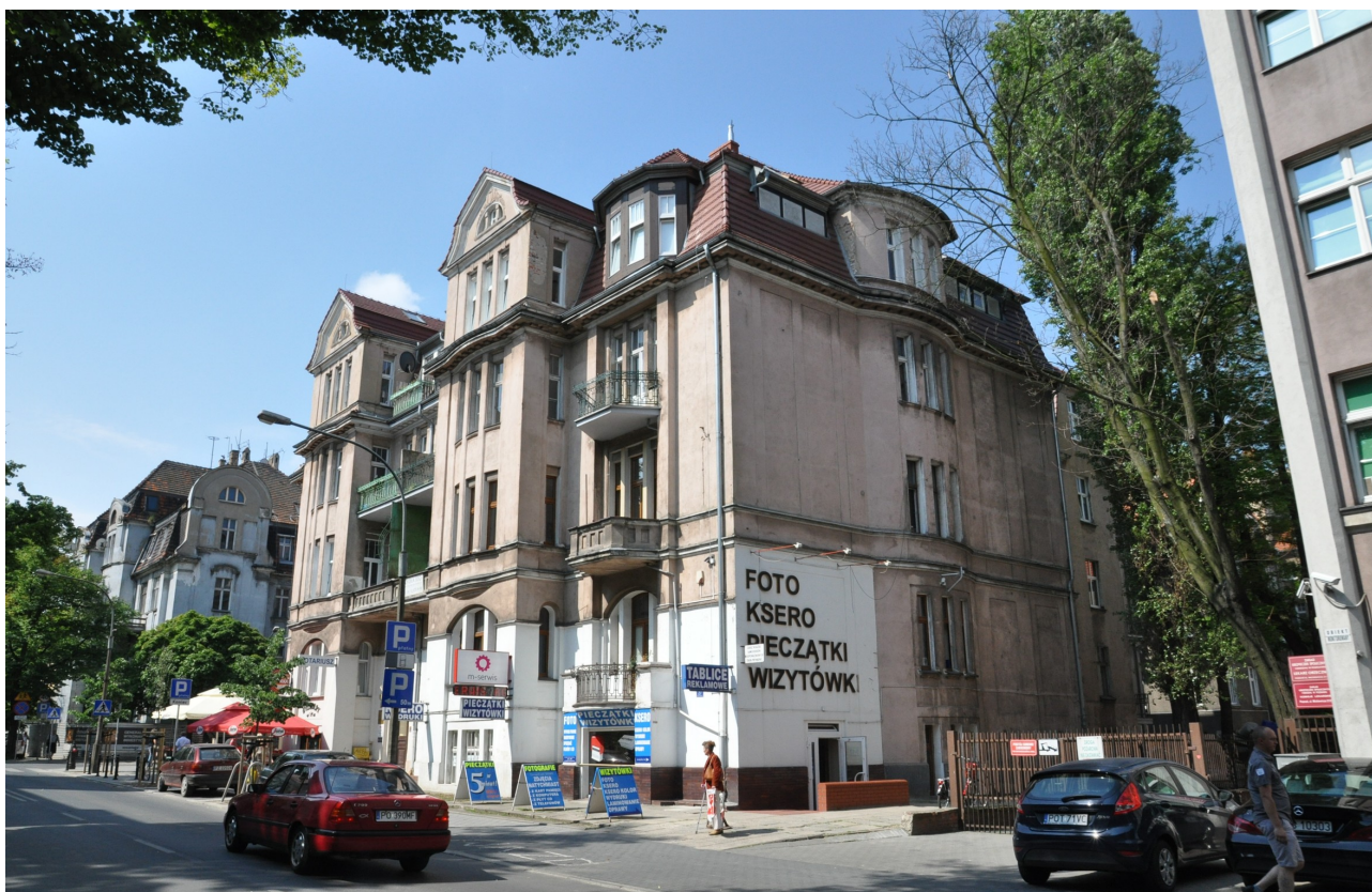
Fot1. Elewacja wschodnia i północna (ul. Mickiewicza)
