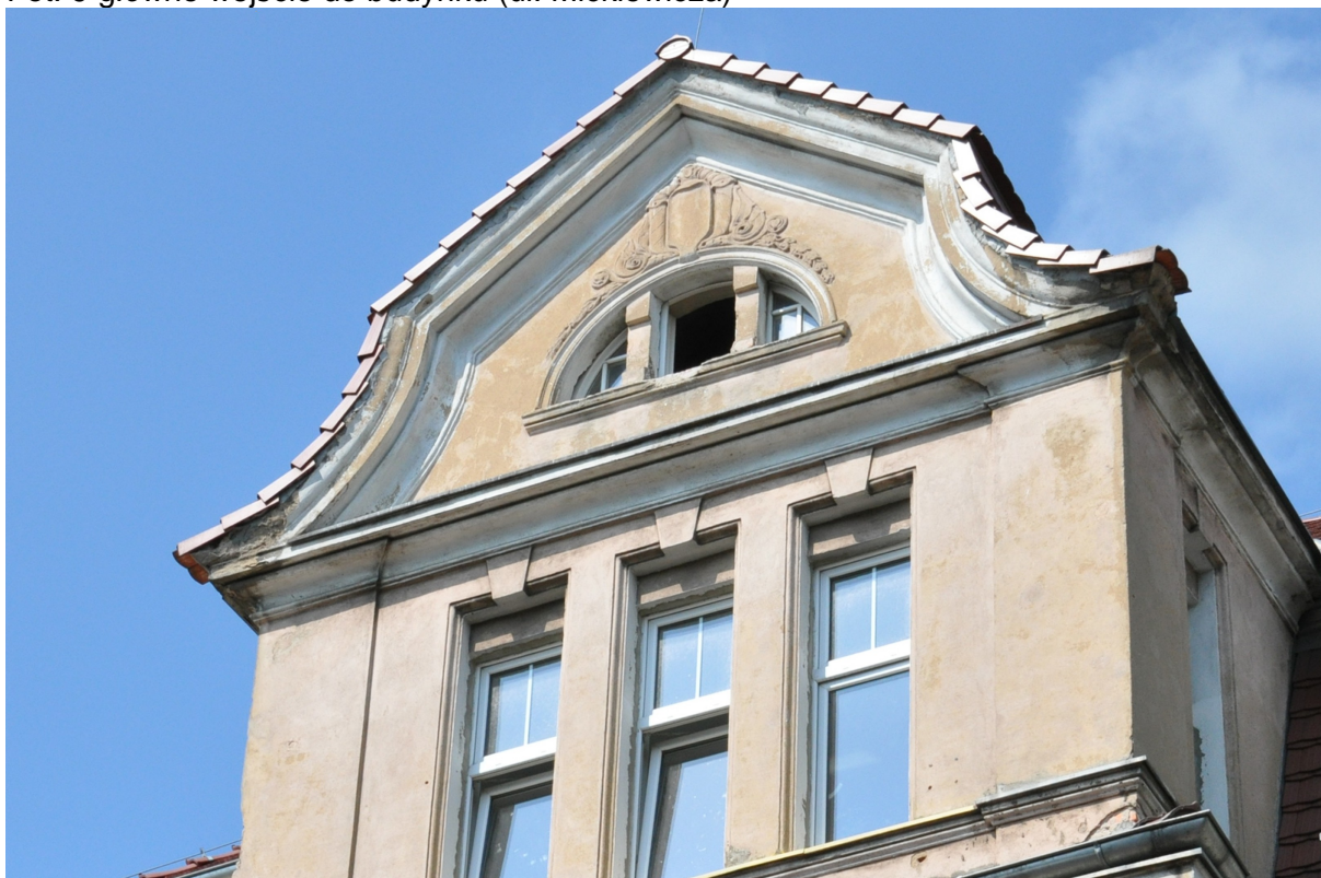
Fot. 10 wykusz (ul. Mickiewicza). Detal sztukatorski nad oknem do przeniesienia na wykusz od strony ul. Słowackiego.
