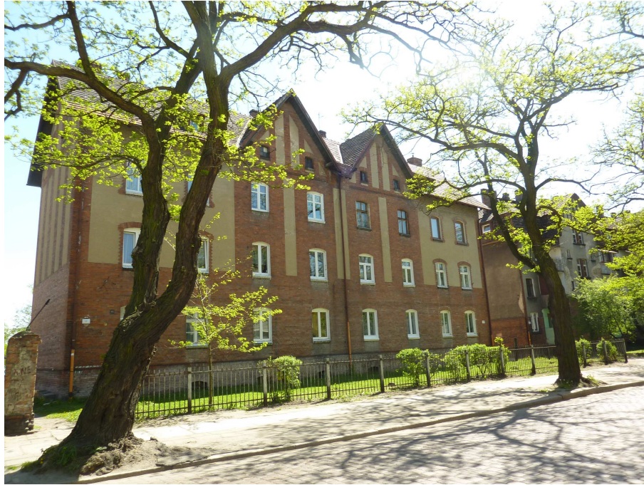
Fot. 1 Budynek wielorodzinny przy ulicy Kolejowej 17 w Poznaniu.
