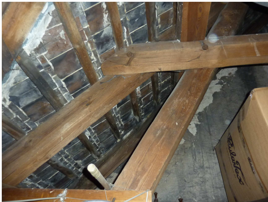
Fot. 2 Widok na płatew pośrednią oraz zastrzał.
