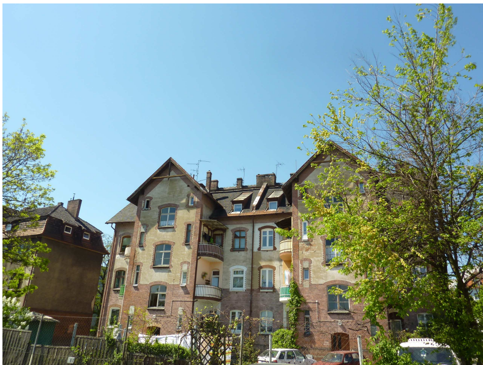
Fot. 4 Elewacja tylna – wschodnia (od podwórza)
