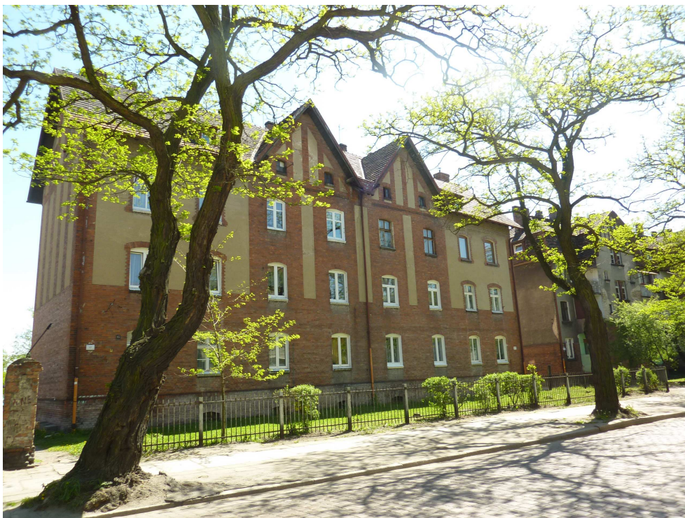
Fot. 1 Elewacja frontowa - zachodnia (od strony ulicy Kolejowej)
