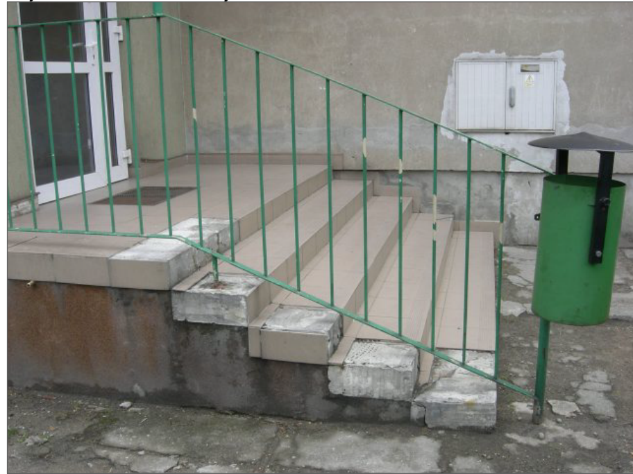
wejście do klatki schodowej
