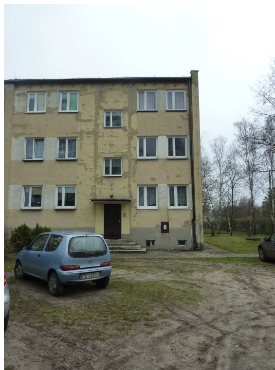
Fot. 2 Elewacja frontowa
