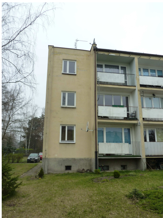
Fot. 1 Elewacja tylna
