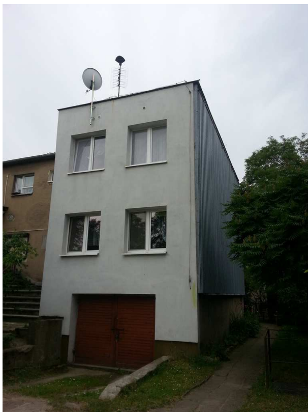
Fot. 3 Elewacja szczytowa - zachodnia
