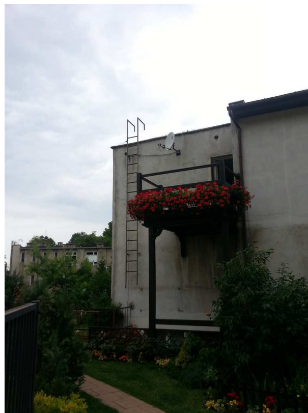
Fot. 4 Elewacja szczytowa - wschodnia
