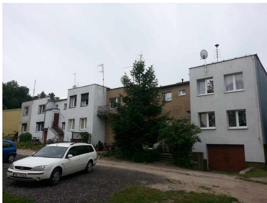
Fot.1 Elewacja frontowa
