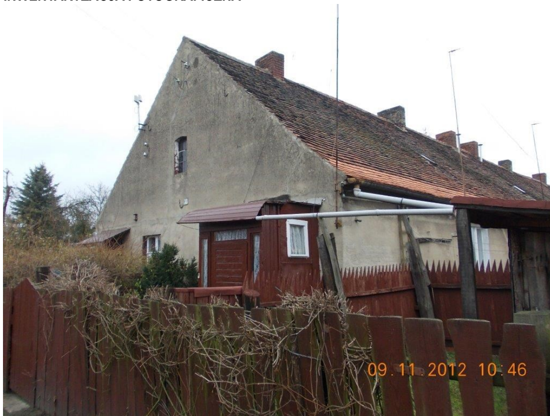
Fot. 1 Elewacja szczytowa zachodnia
