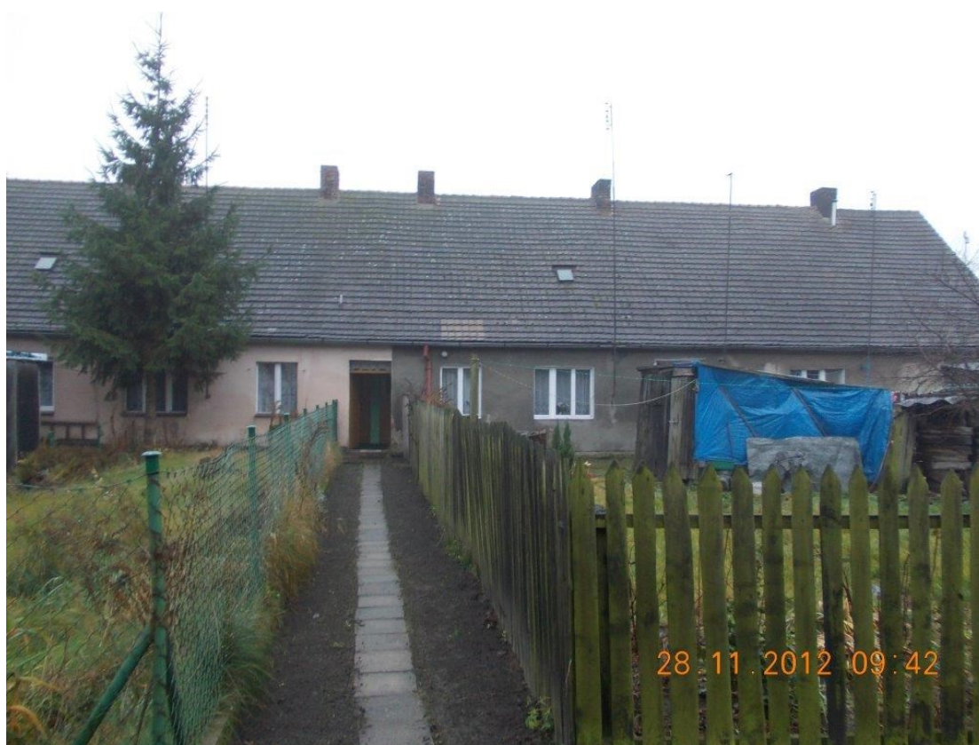
Fot. 2 Elewacja północna
