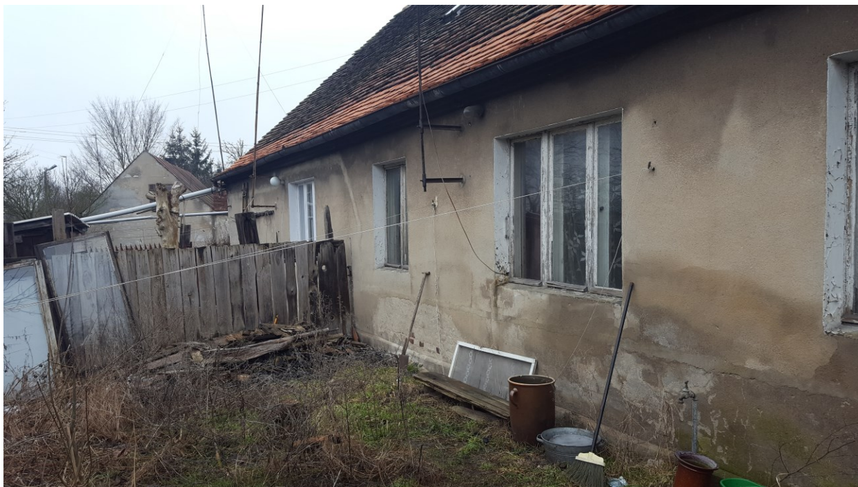
Fot. 3 Elewacja południowa (fragment)
