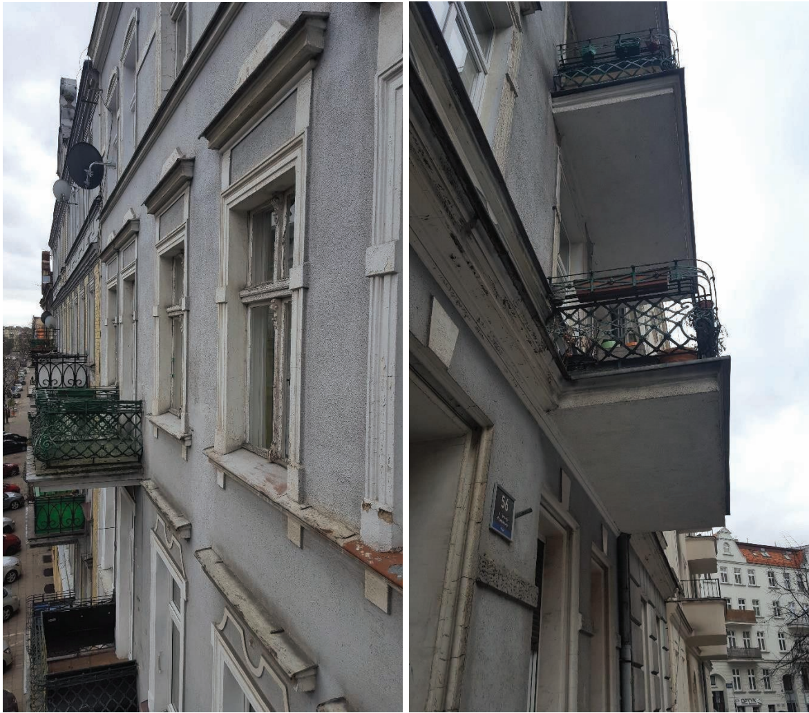
Fot.5, 6. Elewacja frontowa -zblizenie.
