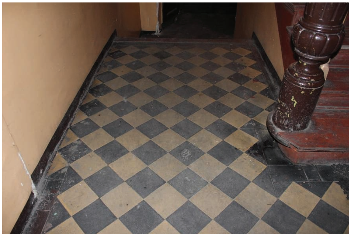
Fot.18. Klatka schodowa – posadzka.
