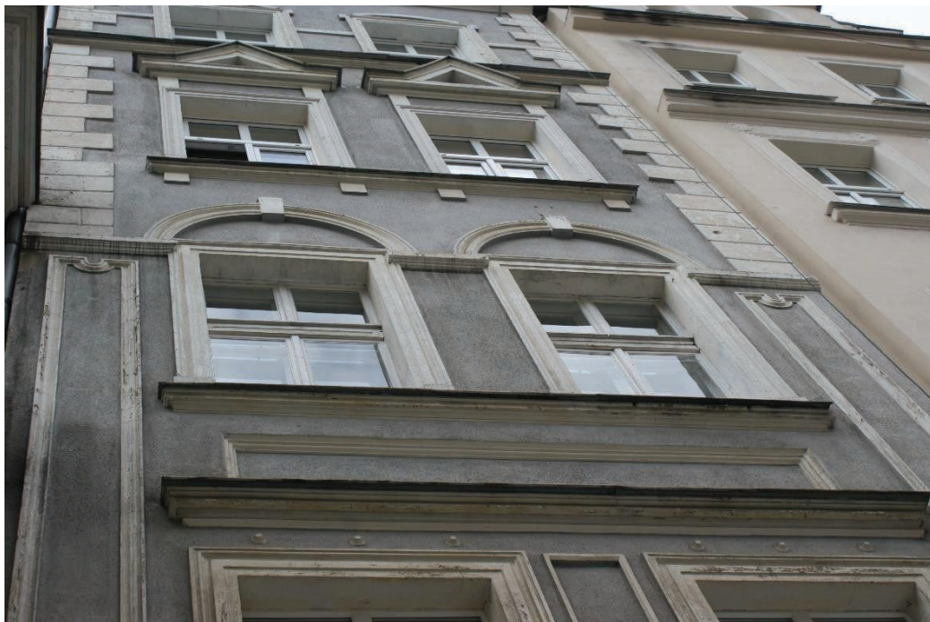
Fot.7. Elewacja frontowa -zblizenie.
