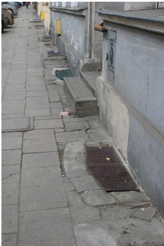
Fot.11. Elewacja frontowa cokół i okratowania powyżej otworów okiennych piwnicznych.
