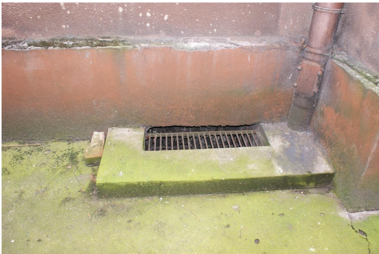
Fot.12. Elewacja zachodnia- cokół i okratowania powyżej otworów okiennych piwnicznych.
