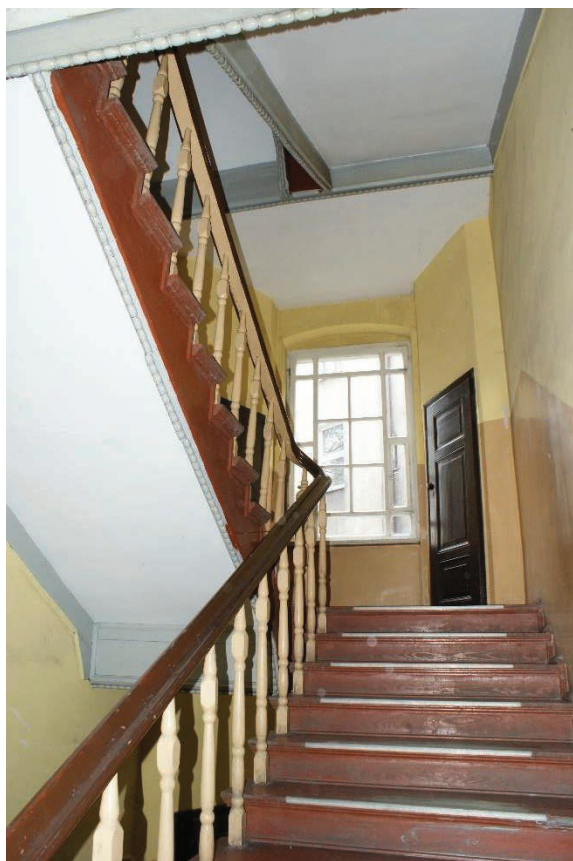
Fot.16. Klatka schodowa.
