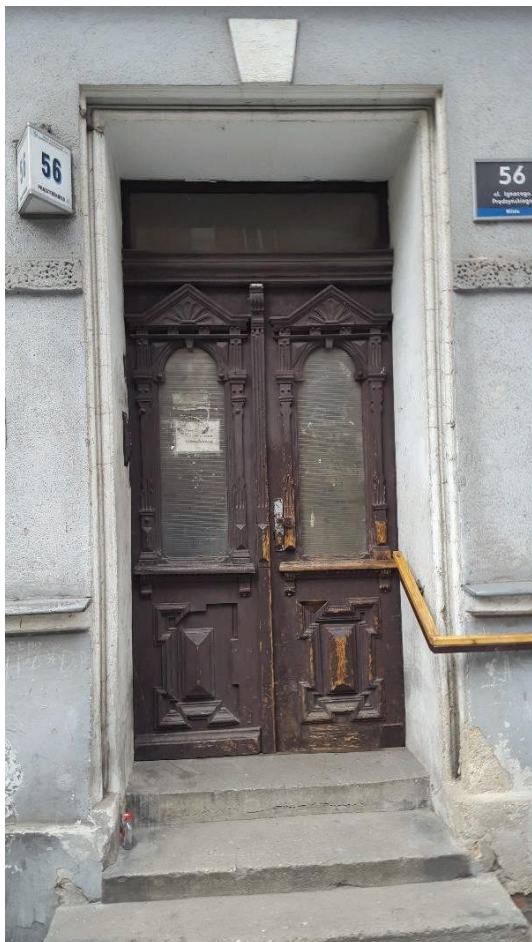
Fot.13. Drzwi wejściowe główne.
