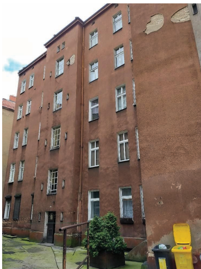
Fot.2. Elewacja od strony podwórza.
