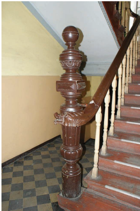
Fot.17. Klatka schodowa -detal.
