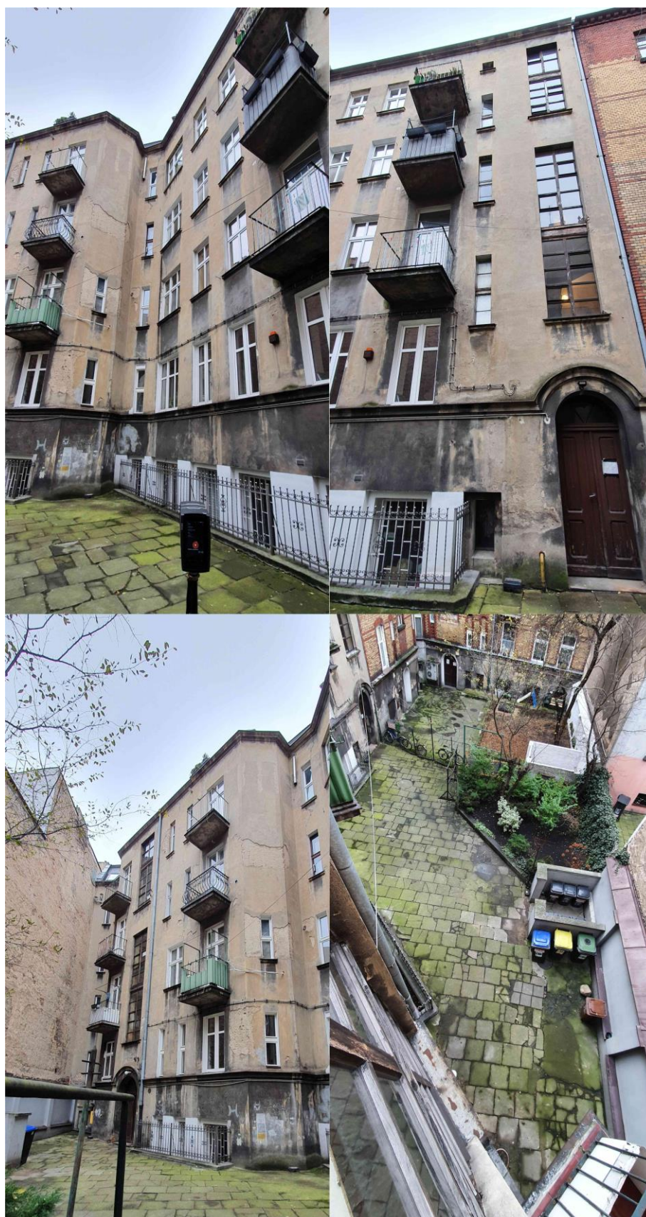
Fot. 1 Elewacje podwórza
