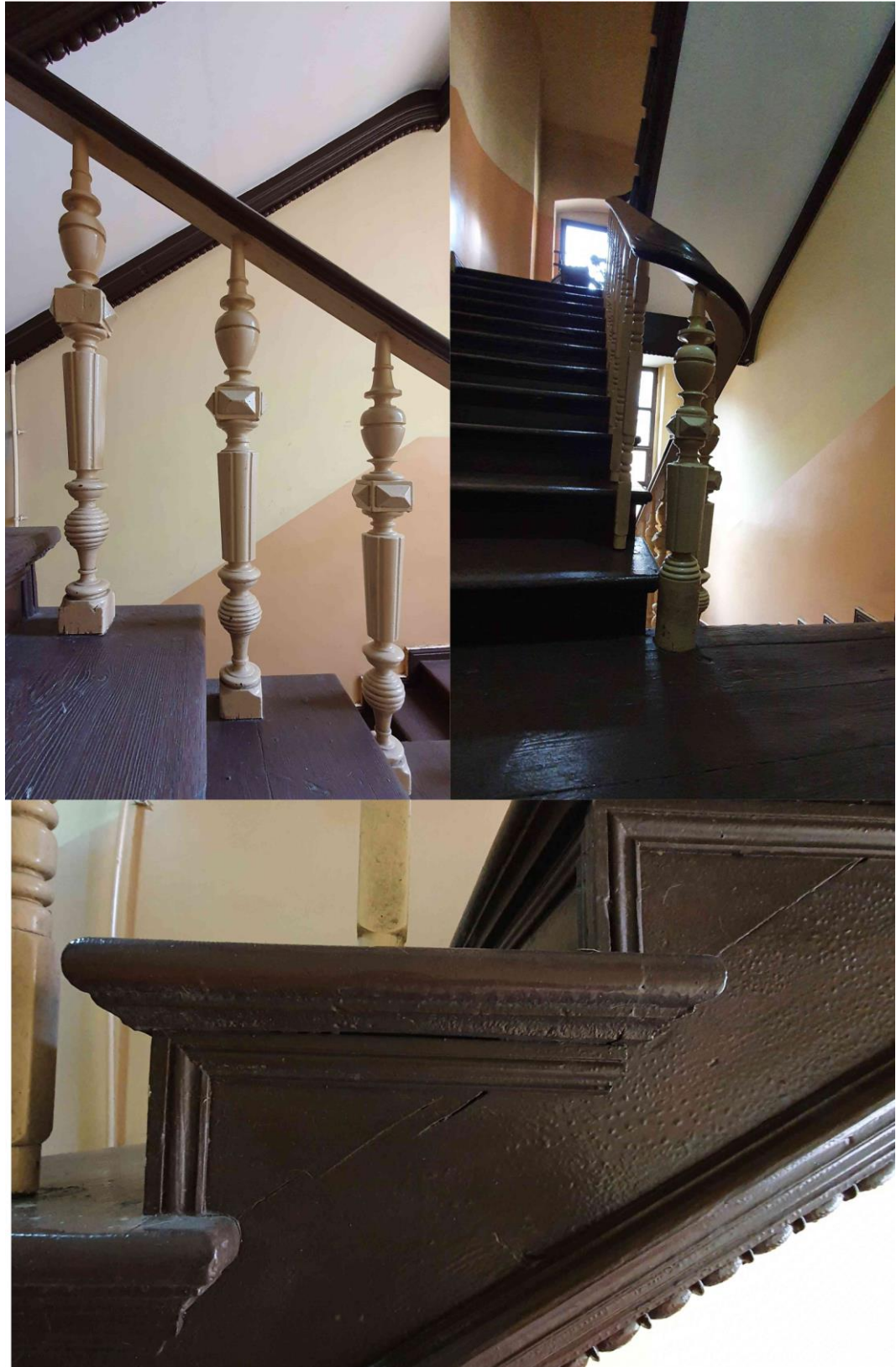
Fot. 2 Klatka schodowa główna
